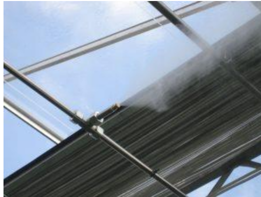
Figura 8.11: Sistemas de humidificación
