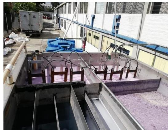
**Fig.4:** Proceso de Electrocoagulación floculación-Coagulación química.
