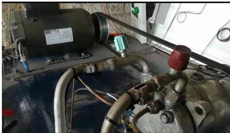
**Figura I. d.** Termostatos y sensores en mal estado
