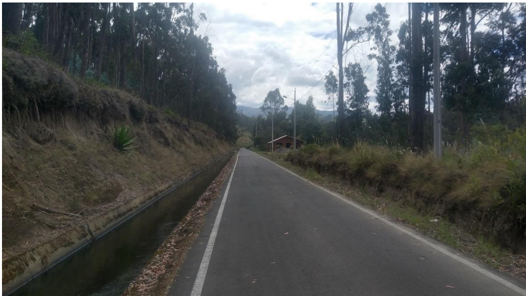
Gráfico 35: Vista del canal Ambato- Huachi -Pelileo
