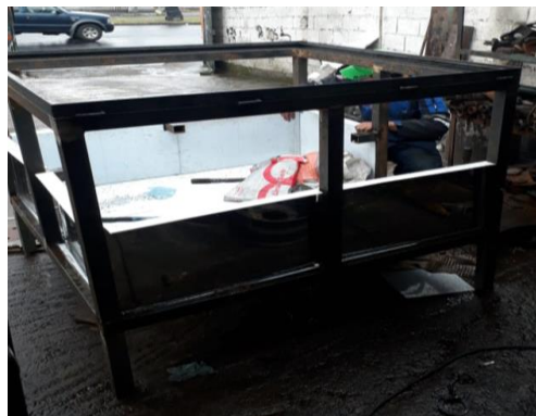
Figura 5. Colocación de la plancha interior
