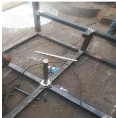
Figura 4. Centrado del eje en la base de la estructura
