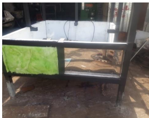
Figura 6. Colocación fibra de vidrio
