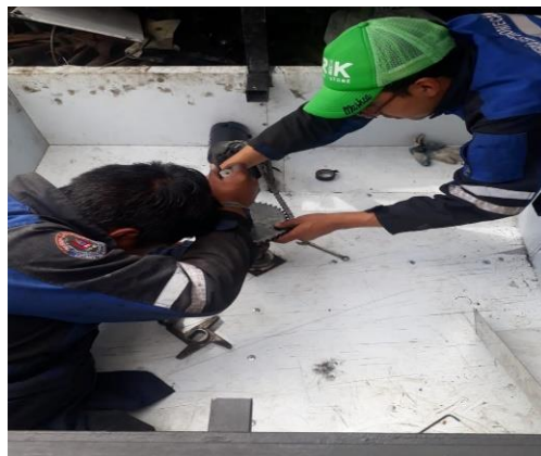
Figura 8. Colocación del eje en la base de la estructura
