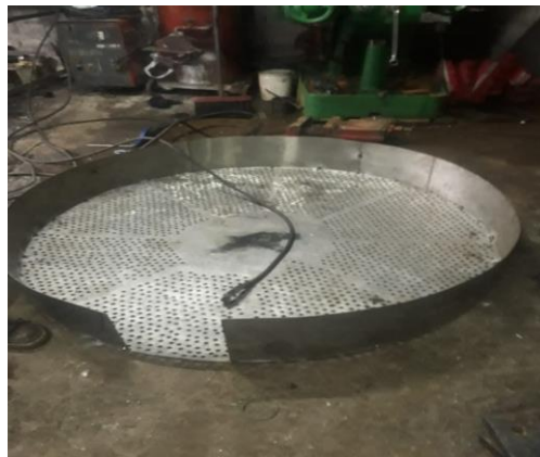
Figura 11. Construcción del contenedor del cacao
