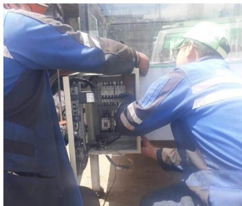
Figura 17: Implementación del tablero
