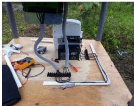
Figura 5. 26. Montaje de los elementos en la base
