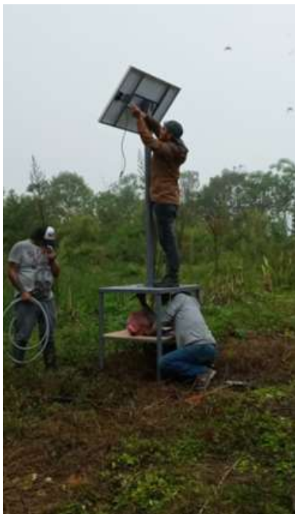
Figura 5. 25. Montaje del panel solar
