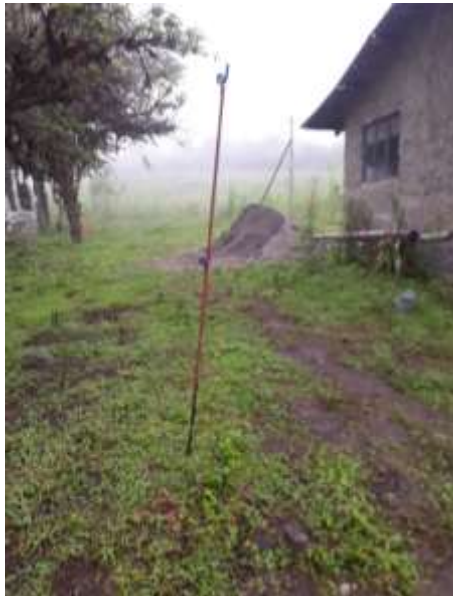
Figura 5. 7. Estaca de varilla con un aislante de manguera térmica
