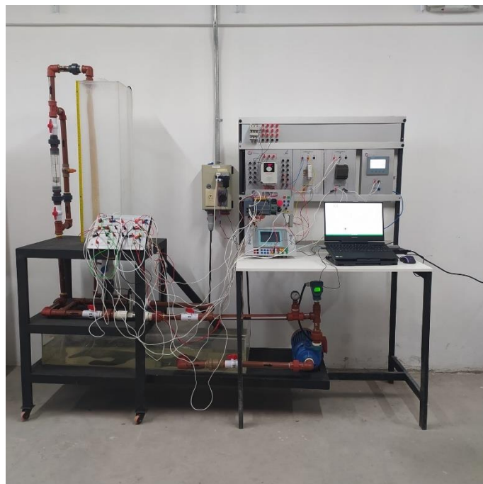
Figura L.1. Estación de bombeo a presión constante
