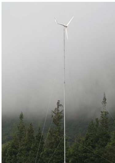
Figura 3.15. Instalación del aerogenerador (Pululahua) [28].
