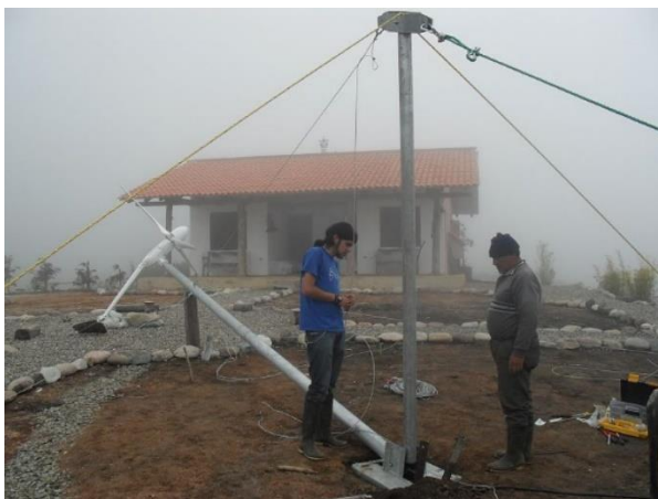
Figura 3.13. Instalación del aerogenerador (Garupamba) [26].
