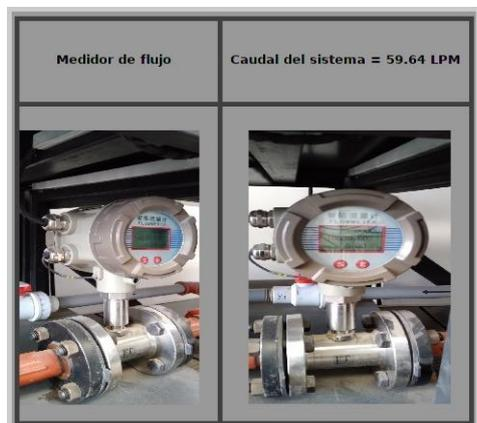
**Figura V.56.** Medición de caudal 2
