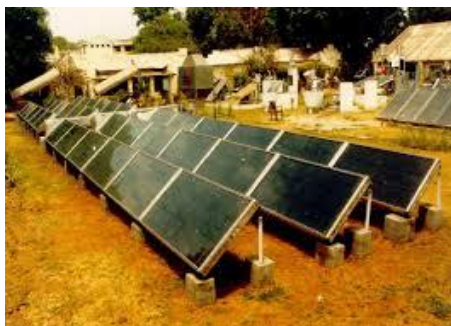
Figura 3.13 Secado Híbrido (GLP y Energía solar) [24].
