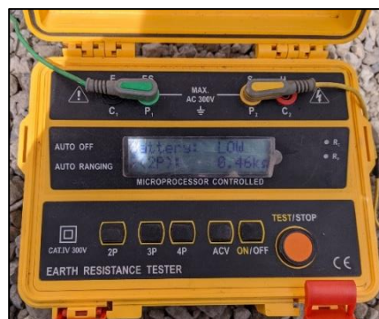
Figura 4. 30. Telurómetro en funcionamiento en el patio de Construcción de redes.
