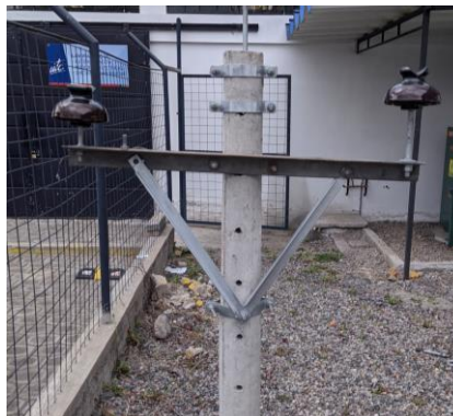
Figura 12. Fijado de la estructura en el poste.
