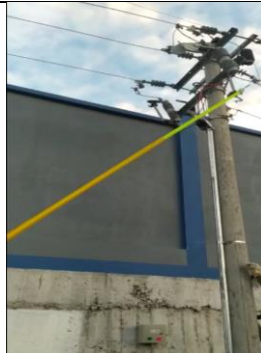
Figura 6. Maniobra del seccionador.
