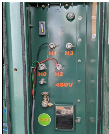
Figura 4. 12. Conexión del lado secundario del transformador.
