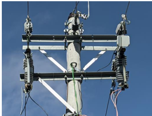
Figura 5. Montaje del seccionador.
