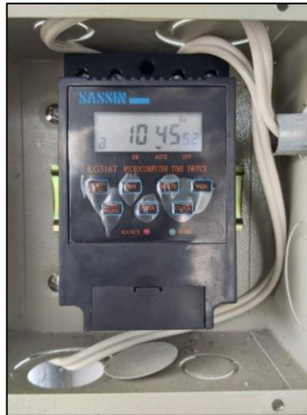
Figura 4. 25. Temporizador de serie KG316T para el control de luminarias.
