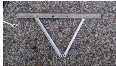
Figura 11. Fijado de los pies de amigo en la cruceta.
