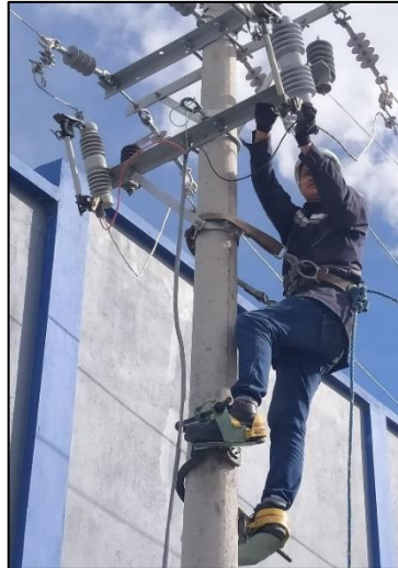
Figura 4. 13. Alimentación de la línea de distribución, desde el transformador Pau Mounted.
