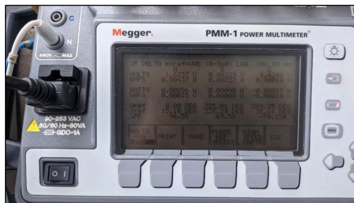
Figura 4. 31. PMM-1 en funcionamiento conectado al transformador Pau Mounted.
