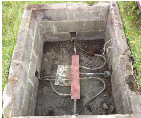
Figura 3. 1. Planchuela de equipotencialización.
