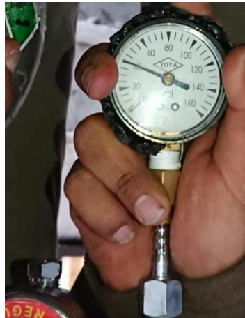
Ilustración 37: Presión de salida del regulador de presión utilizado en la máquina.
