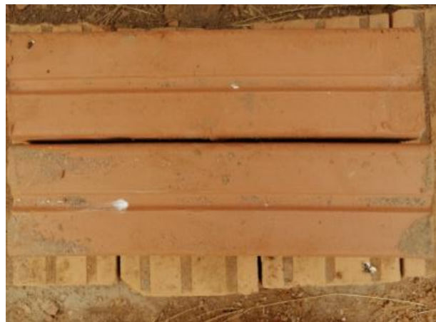
Gráfico 31. Ladrillos con defectos en el tamaño.
