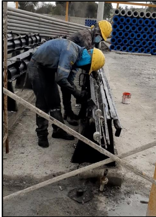
Armado de moldes.
