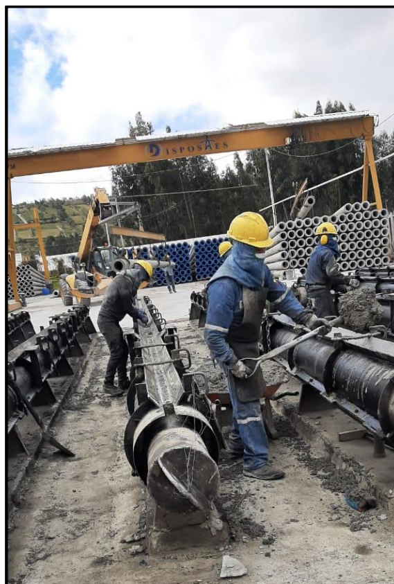
Trabajos realizados en el área de producción.
