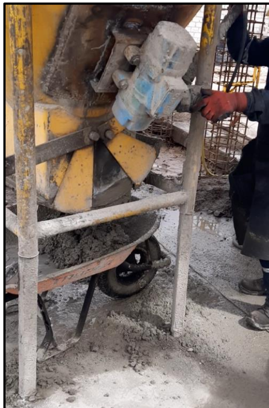
Hormigón depositado en la carretilla listo para su transporte.
