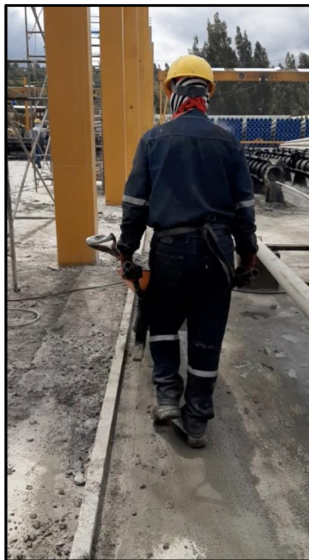
Transporte del hormigón.
