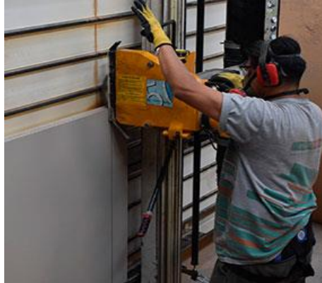
Figura 12: Proceso de corte de tablero. [18]
