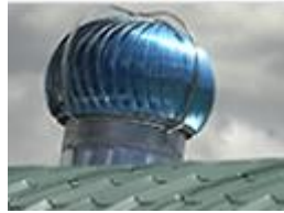
Figura 3.15. Ventilación natural basada en las fuerzas del viento [13].
