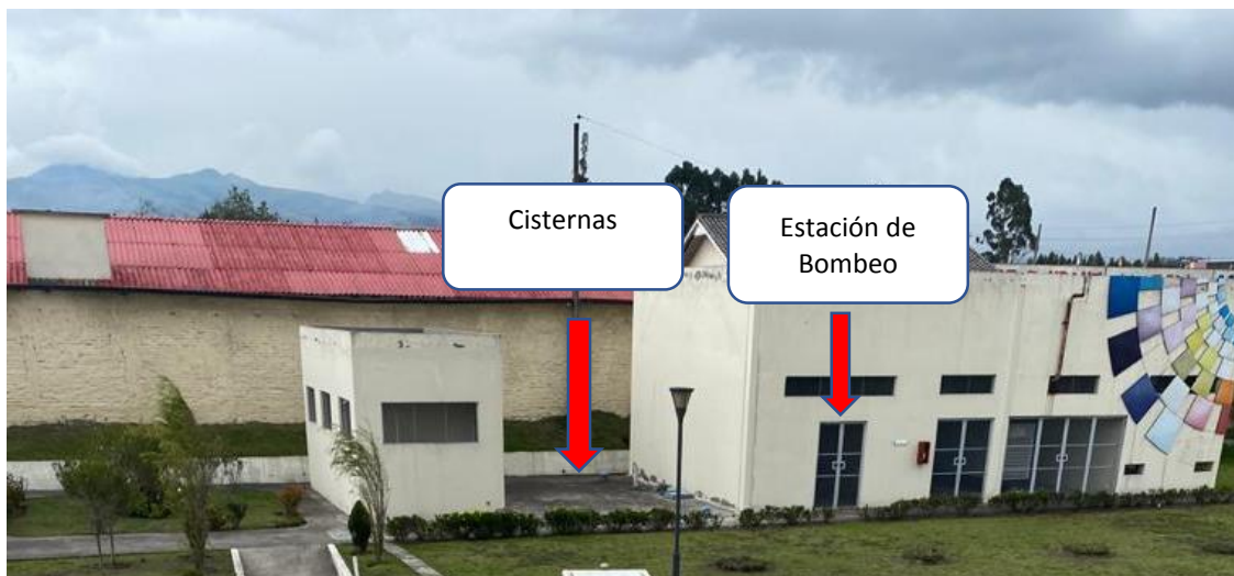
Figura N°14: Caseta de Bombeo Fuente: Los Autores
