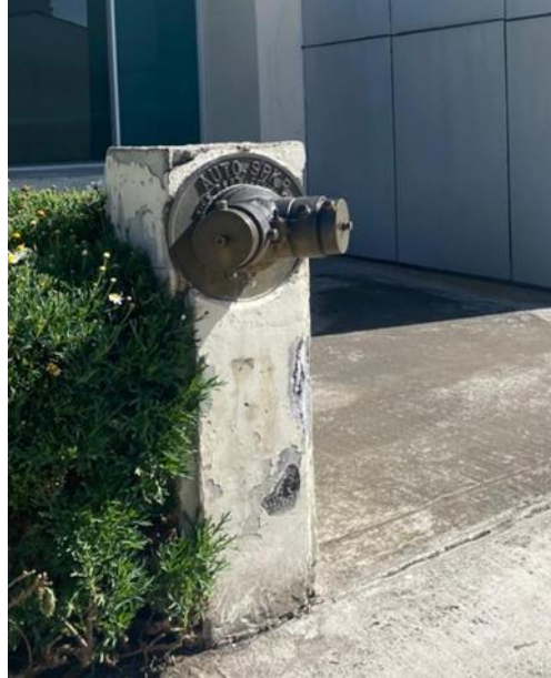
Figura N°23: Siamesa de Conexión de Bomberos
