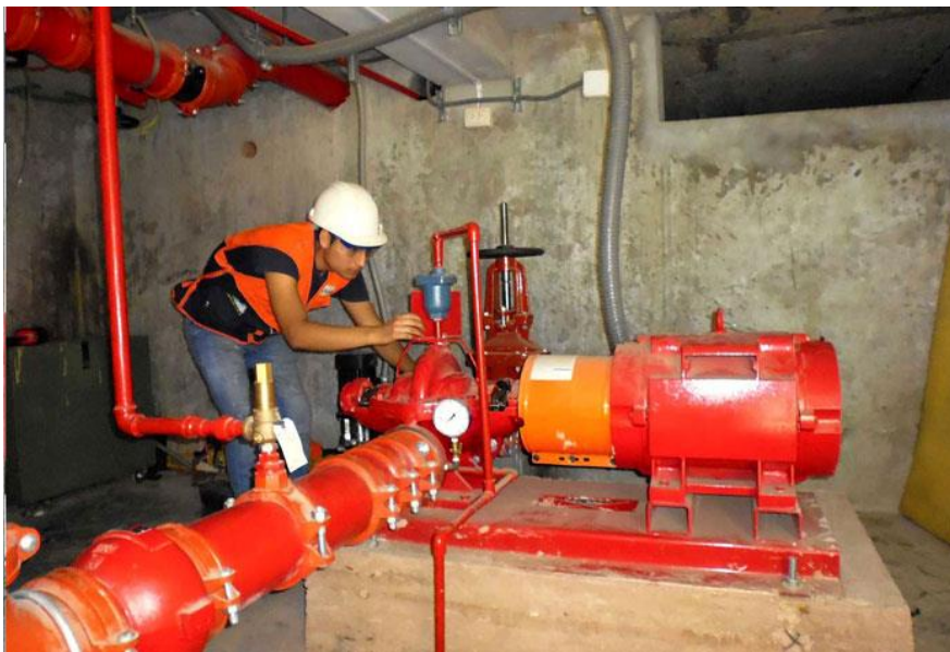
Figura N°35: Desarrollo de la prueba hidrostática
