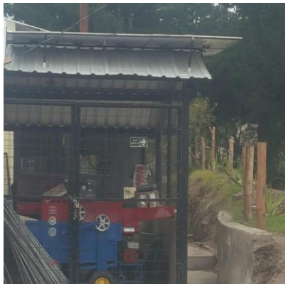
Fig. 19 Ubicación de los Paneles Solares
