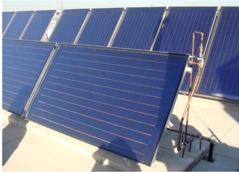
Figura 3 Colector solar plano no protegido [12].
