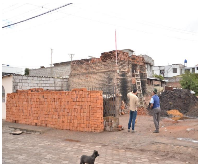
Fotografía 4.- Horno utilizado en la quema de ladrillos
