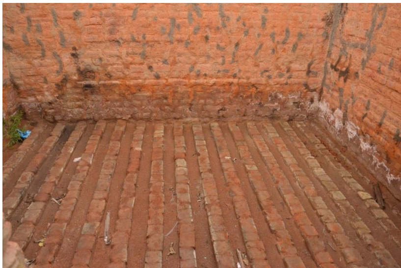
Fotografía 7.- Plataforma para colocación de ladrillo
