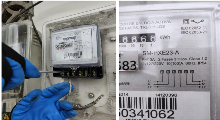
Figura 39: Diagrama eléctrico y conexión de cable neutro
