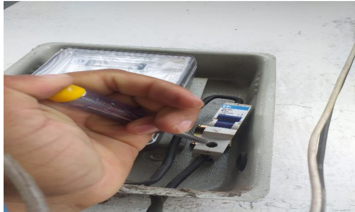
Figura 37: Verificación de las líneas
