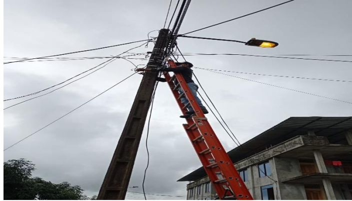
Figura 41: Energización de las líneas
