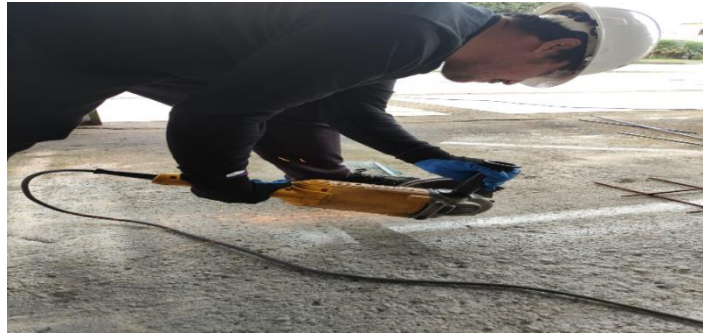
Figura 29: Corte de los tubos galvanizados
