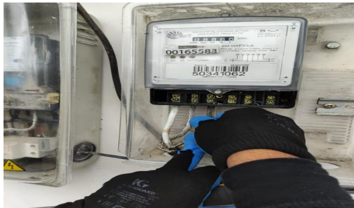
Figura 40: Instalación de las líneas salientes
