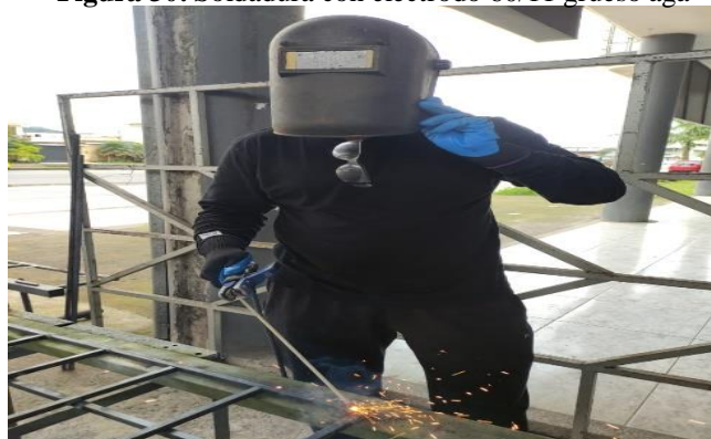
Figura 30: Soldadura con electrodo 60/11 grueso agá
