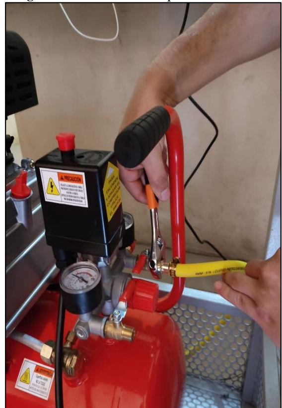
Imagen 6: Instalación del compresor en el módulo
