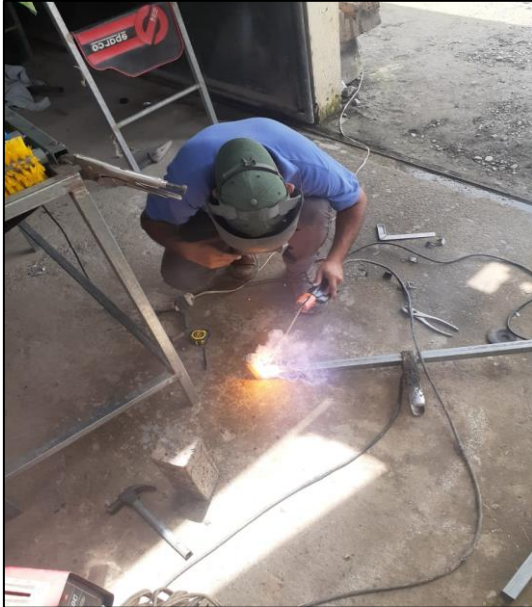
Imagen 26: armado de estructura
