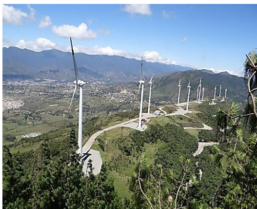
Figura 2. Parque Eólico Villonaco
