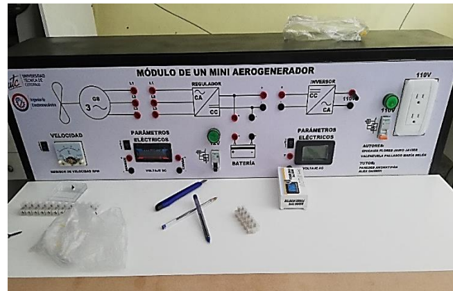
Figura 45. Montaje de equipos y elementos en el tablero de MDF
