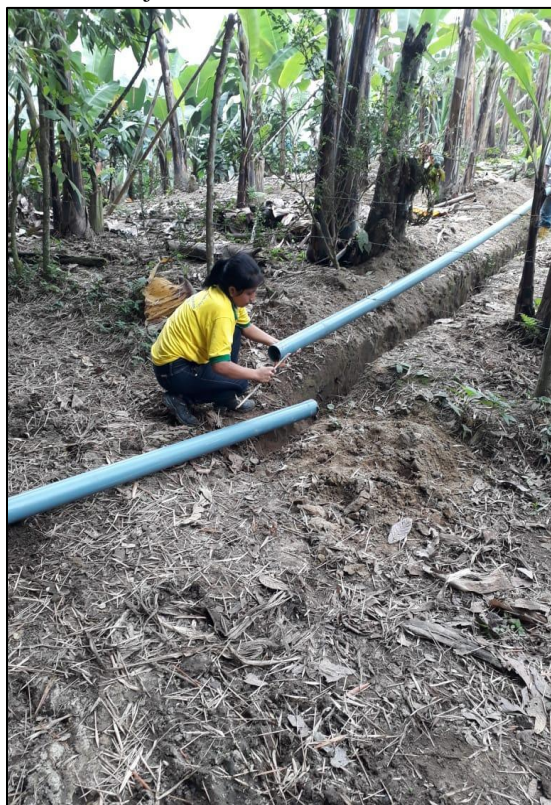
Fotografía 8: Tendido de tuberías principales y porta laterales en las zanja
