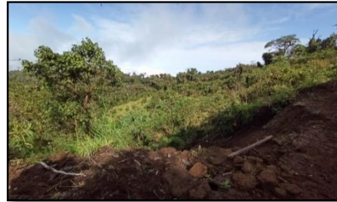
Fotografía 8 Deslizamiento de tierra
