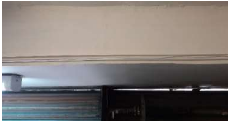
Imagen 86 Instalación de canaletas
