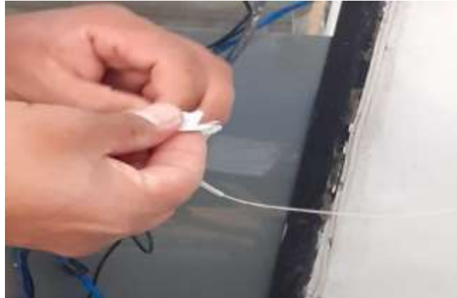
Imagen 72 Limpieza de los hilos de fibra
