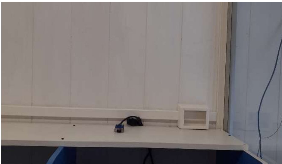
Imagen 87 Instalación de Jacks de pared
