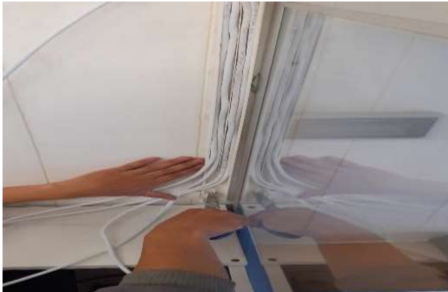
Imagen 39 Instalación de cables UTP
