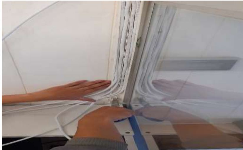
Imagen 88 Instalación de cables UTP CAT6E
