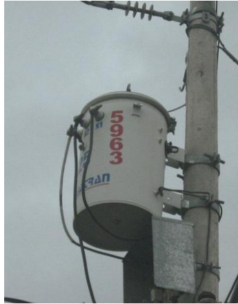
GRÁFICO N° 1.2 TRANSFORMADOR DE DISTRIBUCIÓN
