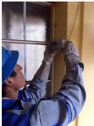
Instalación del display
