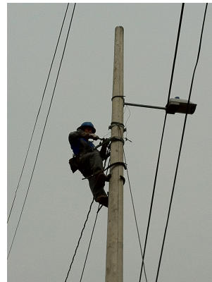
Instalación de acometida
