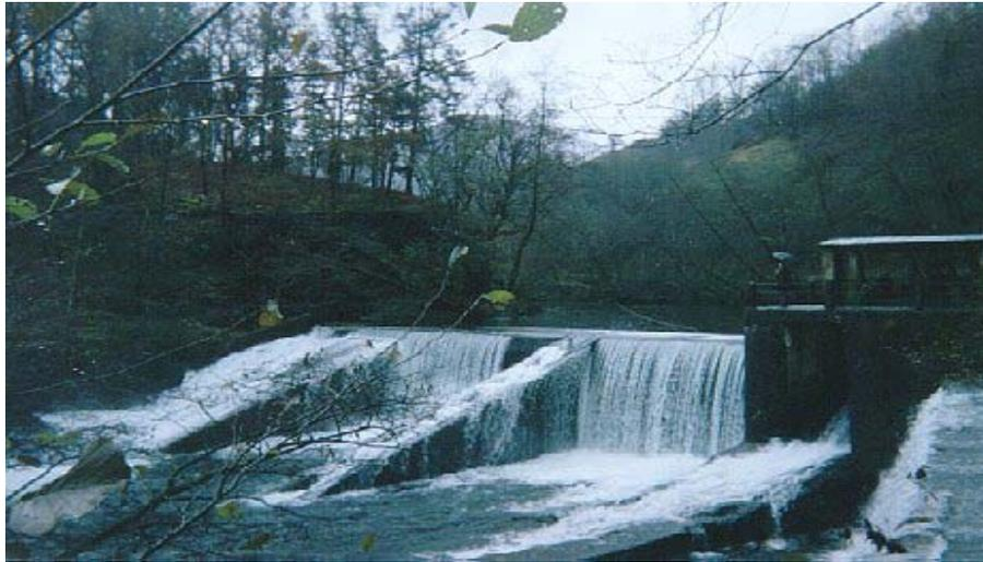
Los sistemas de agua que fluye no tienen porque ser de derivación, pueden ser centrales directamente situadas en el mismo cauce del río que aumentan el salto de agua mediante un azud.
