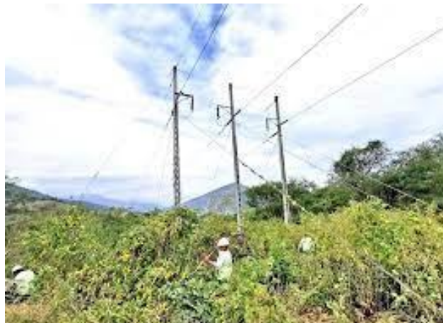
Figura 6. Desbroce de vegetación de redes eléctricas [17].
