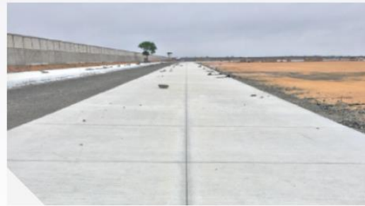
Pavimentos en concreto
