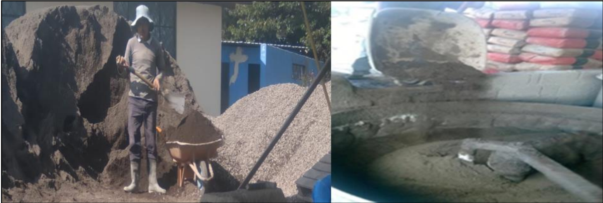
Anexo 21: Proceso de dosificación y mezclado
