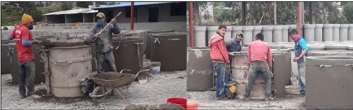
Anexo 25: Producción de tubos de 100 cm de hormigón
