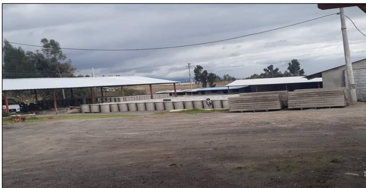
Anexo 17: Instalaciones de la Fábrica de Tubos "Jesús del Gran Poder"
