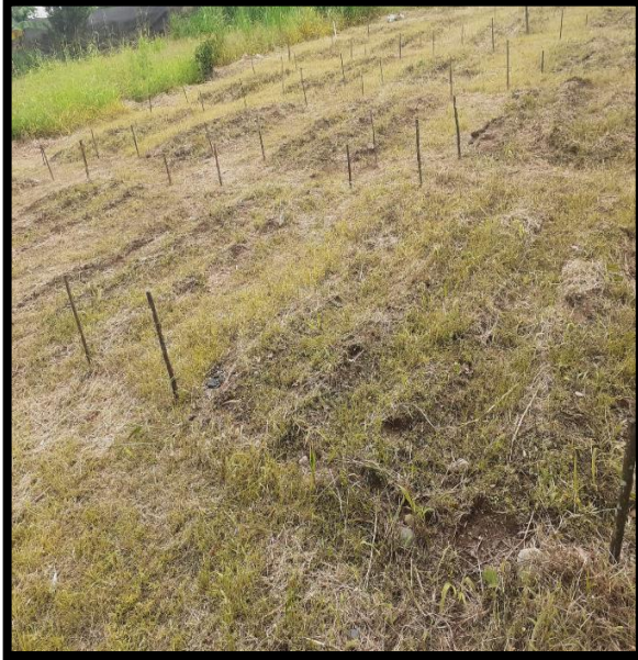
Fotografía 1. Limpieza y adecuación del terreno
