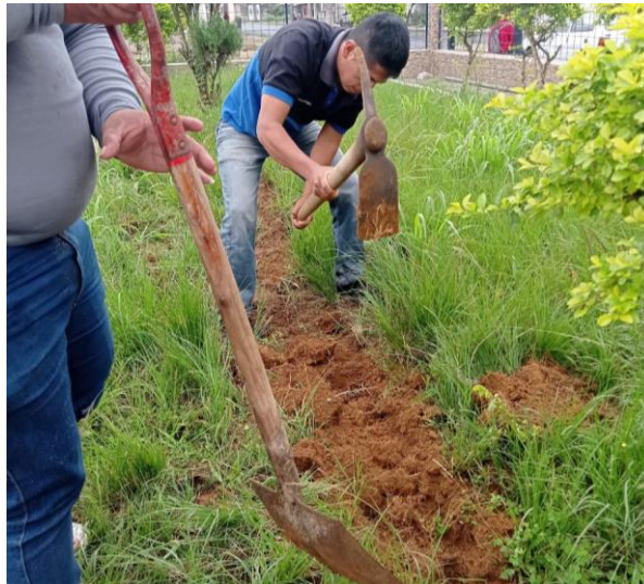
Figura 14. Ubicación de la tubería para el cableado
