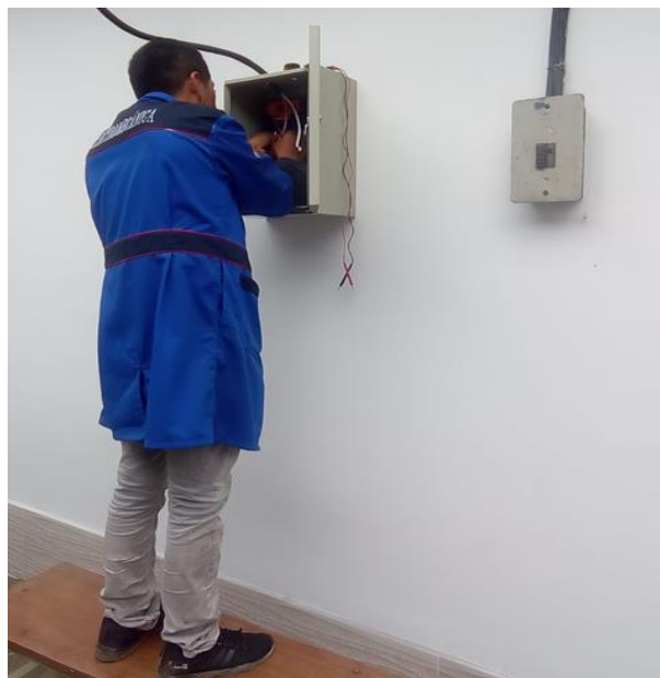
Figura 17. Puesta de la caja de control eléctrico
