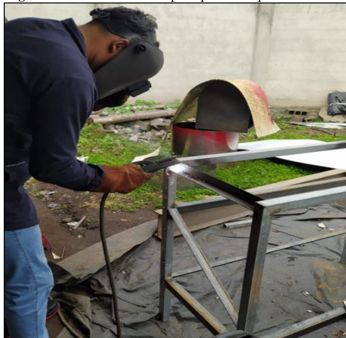
Figura 42: Construcción del soporte para la máquina
