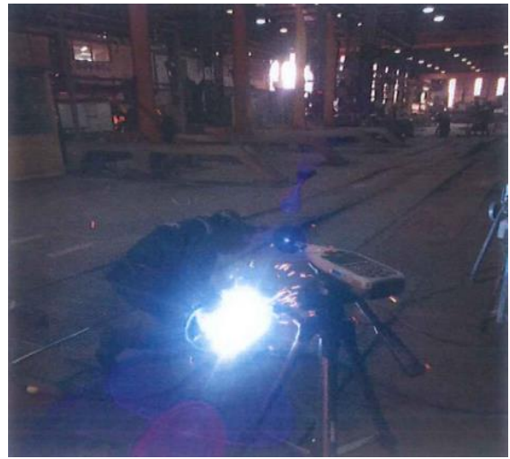
Armado y soldadura línea 5
