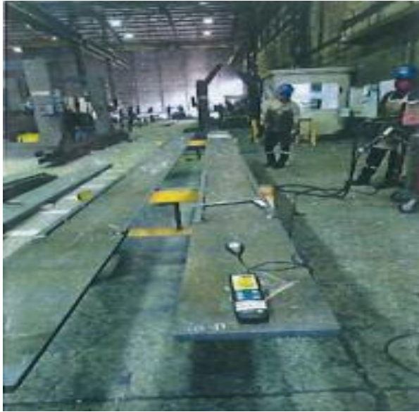
Armado y soldadura línea 1(1)
