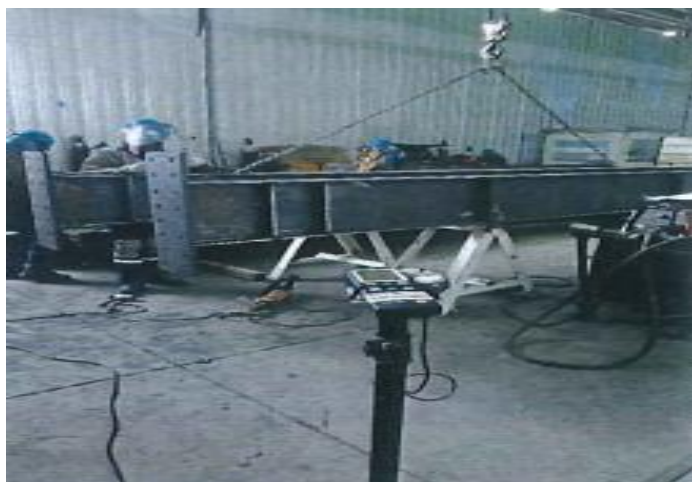
Armado y soldadura línea 2 (2)
