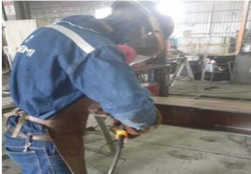
Monitoreo de vibración mano brazo – P1: Amoladora disco de grata – Línea de armado Nro. 4
