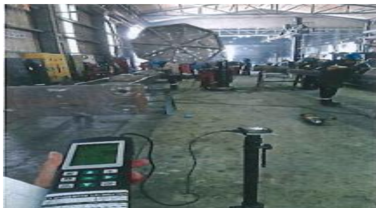
Armado y Soldadura línea 4
