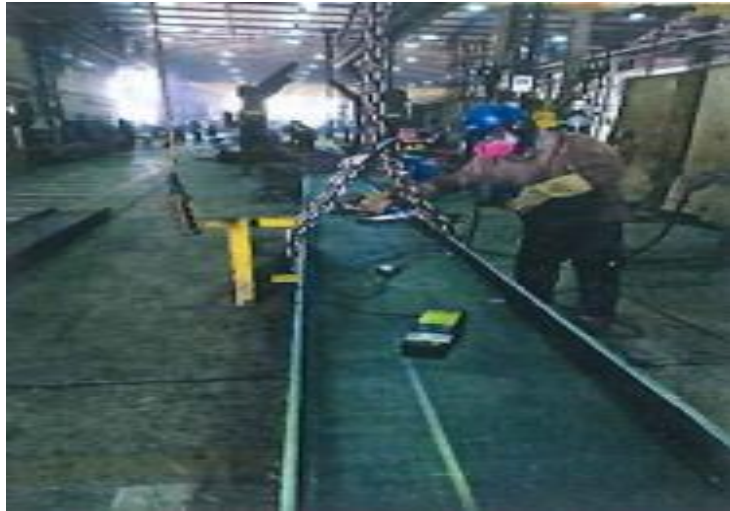
Armado y Soldadura línea 1(2)
