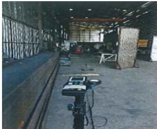
Armado y Soldadura Línea 2(1)
