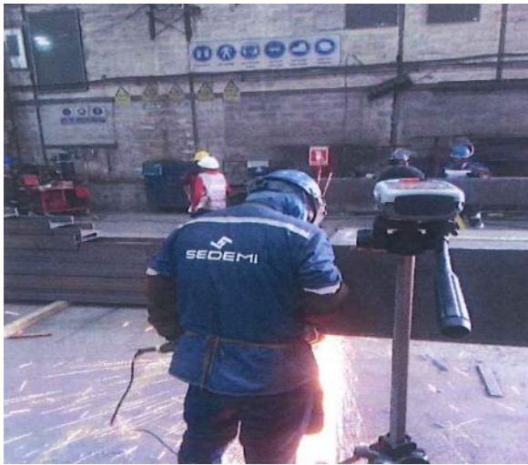
Armado y soldadura línea 1
