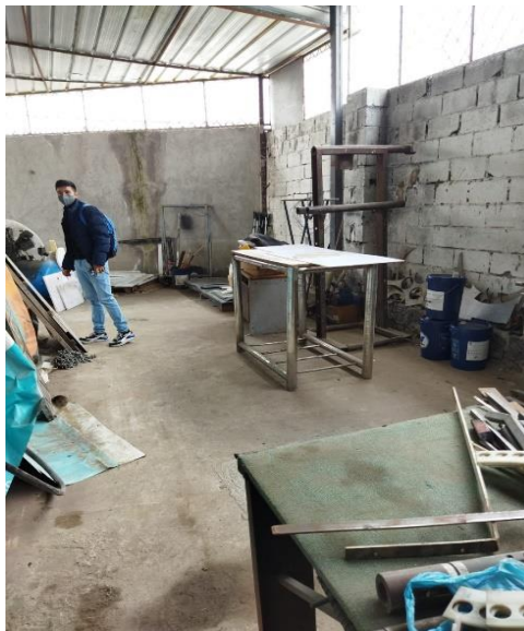
Figura 5.4. Vista interna de la nave N°2.
