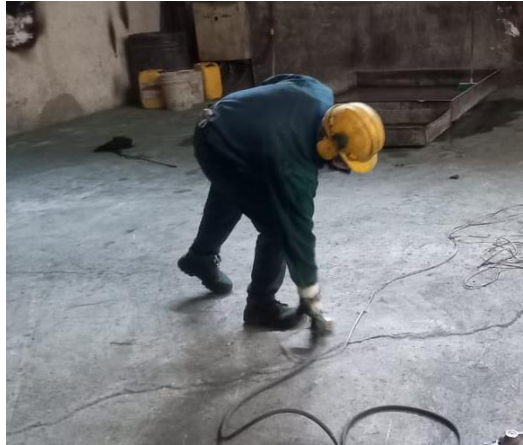
Figura 3.18. Proceso de Limpieza con disolventes GREAT CONTAINER, (1)
