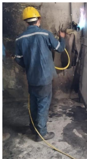
Figura 3.17. Proceso de Conformado GREAT CONTAINER, (1)
