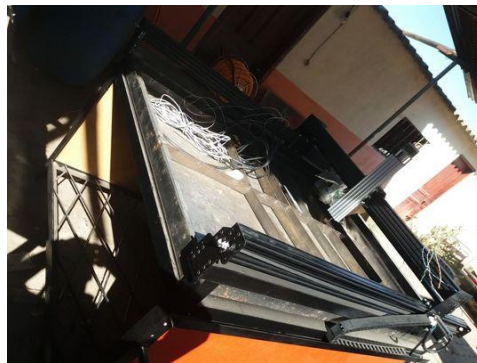
Figura 20. Colocación de la cama base.
