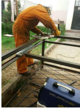
Figura 7. Medición de longitud a cortar.
