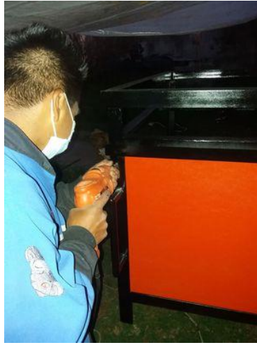
Figura 31. Perforación para agujeros de pernos de fijación de tríplex.
