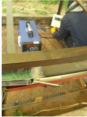
Figura 4. Soldadura de base inferior en la base.
