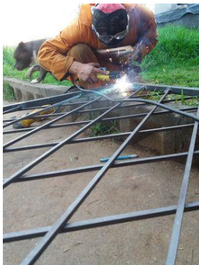
Figura 3. Soldadura de base inferior 1
