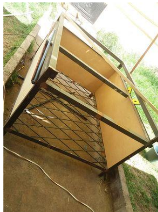
Figura 9. Colocación de trípex en la base.
