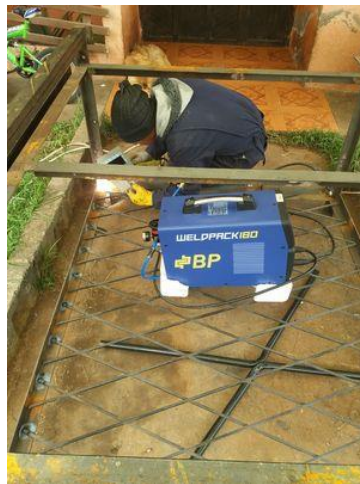
Figura 5. Soldadura de base inferior en la base 1.
