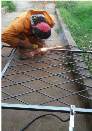
Figura 2. Soldadura de base inferior
