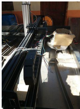
Figura 24. Fijación de la oruga que cubre los cables.
