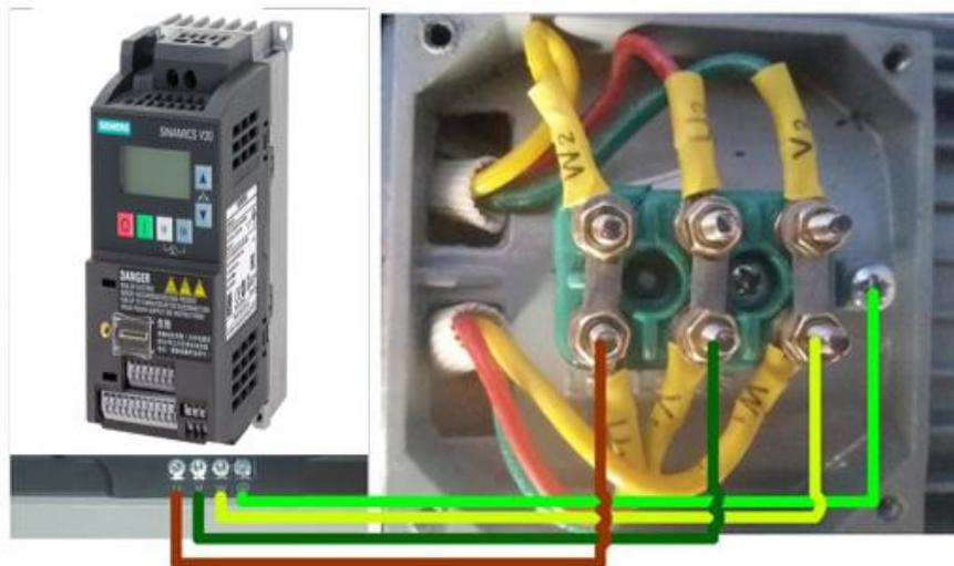
En el caso de variador los terminales del motor deben in conectados en las entradas U, V y W. los cuales se encuentran en la parte de abajo del variador.
