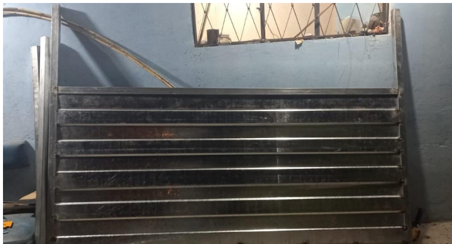
Figura E.1. Implementación de soporte para tuberías.
