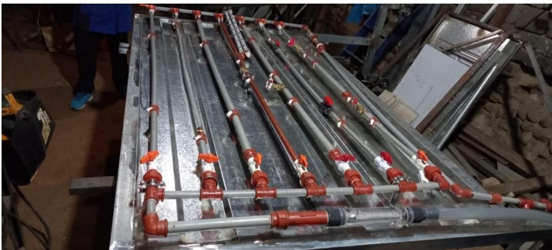
Figura E.4. Ensamble de tuberías y estructura.
