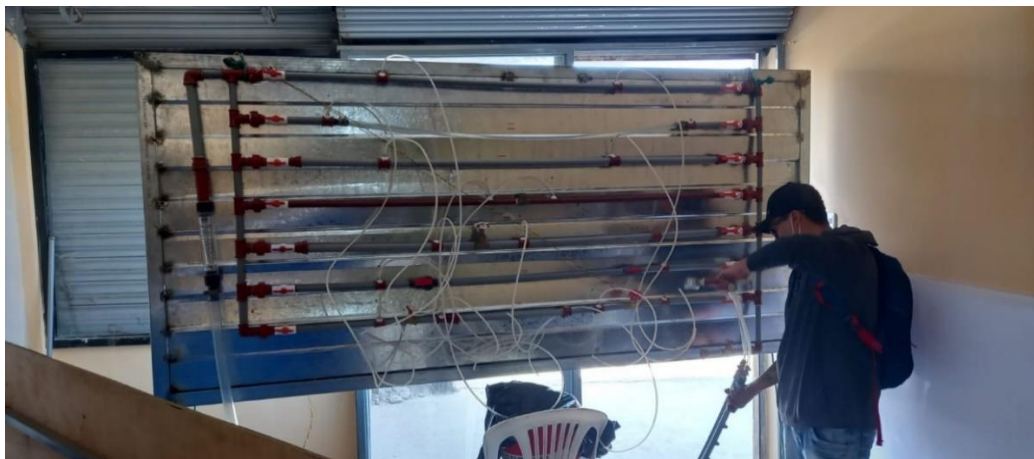
Figura E.6. Instalación de puntos de presión a medir para respectivas pruebas.
