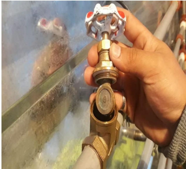
a) Obturador tipo compuerta
