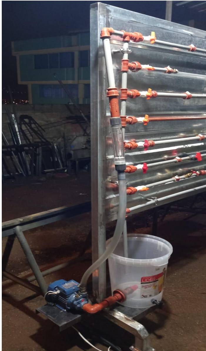
Figura E.5. Instalación de bomba de agua y tanque de retorno.
