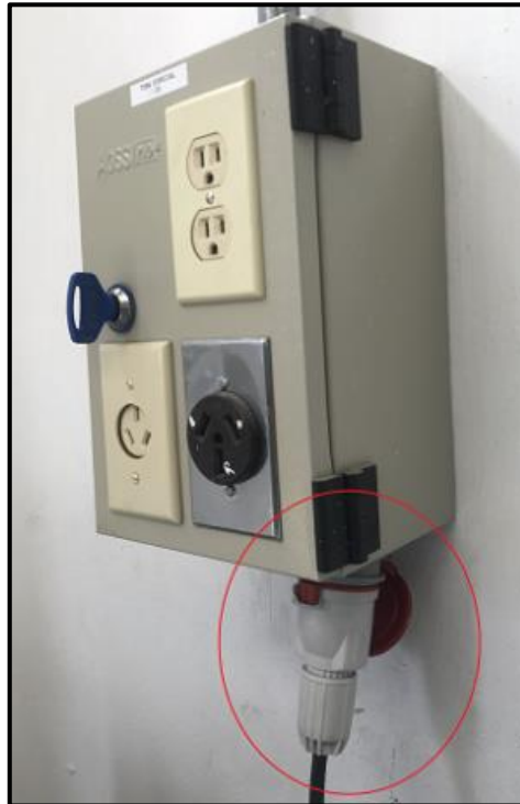
Figura 3. Conexión del módulo al suministro eléctrico
