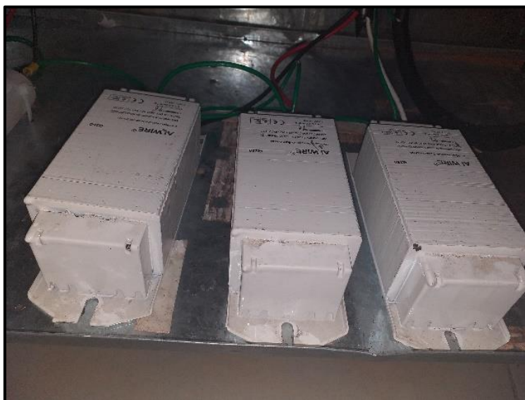
Figura 10. Balastos de 250 W
