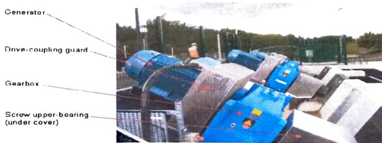
**Figura 2.** Partes principales en el extremo superior de un generador de turbina hidráulica de tornillo de Arquímedes. [12].
