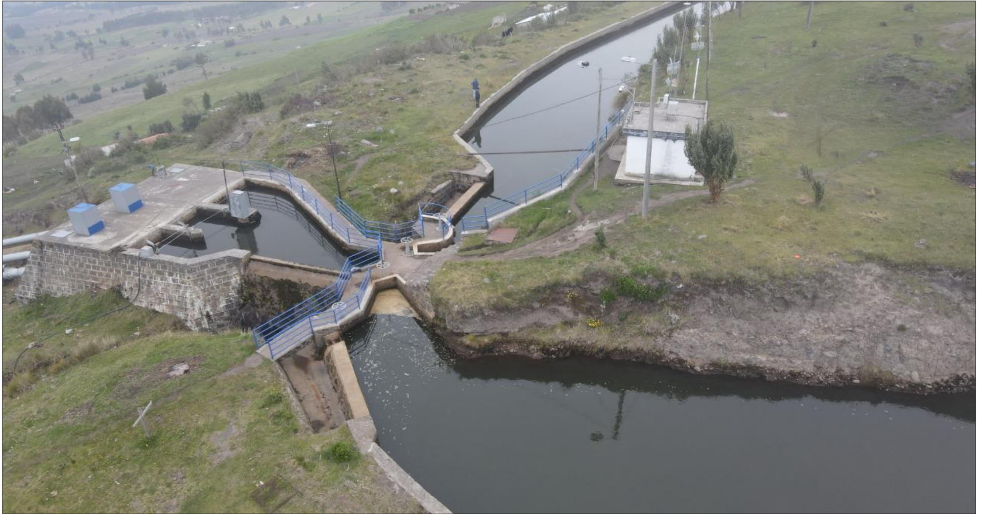
Figura A1: Tanques de la central hidroeléctrica Illuchi 1
