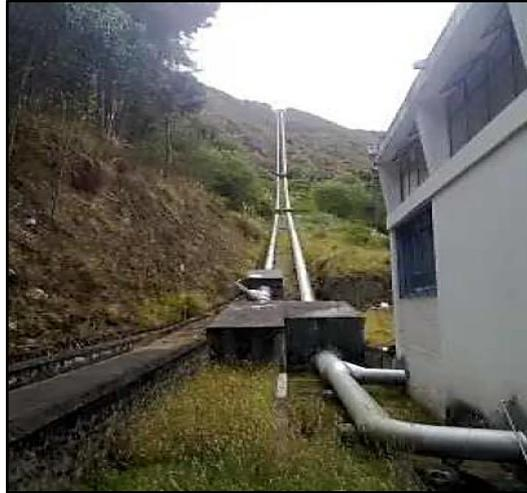
**Figura 4.3.** Tubería de presión perteneciente a la CENTRAL HIDROELÉCTRICA ILLUCHI 2 [15]
