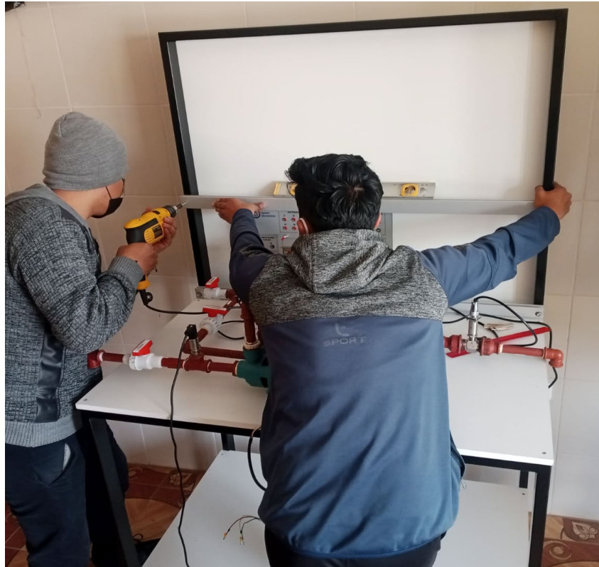
Figura E.4. Instalación de los perfiles de aluminio.
