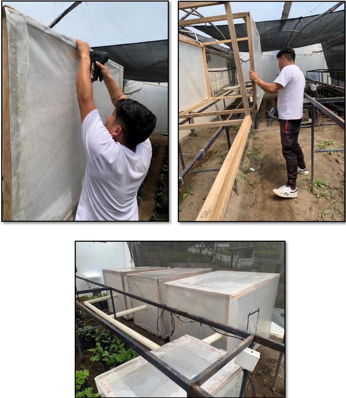
*Fotografía 7. Elaboración de cajas para la inyección de CO<sub>2</sub>*
