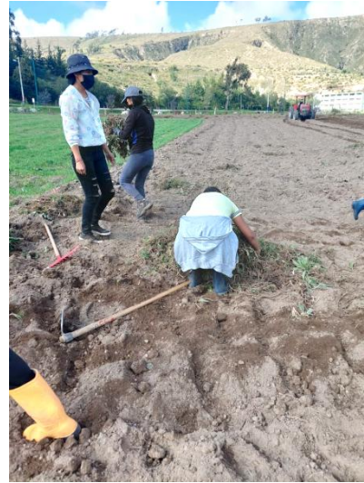
Ilustración 27. Limpieza y nivelación del lote.
